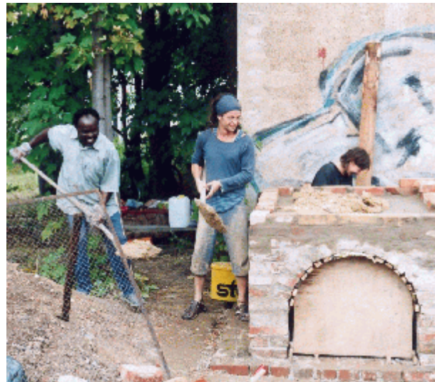
Bau eines Lehmofens
