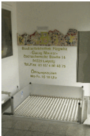
Hebebühne zum Erdgeschoss
